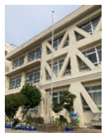
国旗掲揚塔建設 (S36年)
