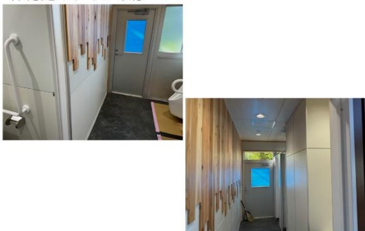
体育館のトイレ改修
